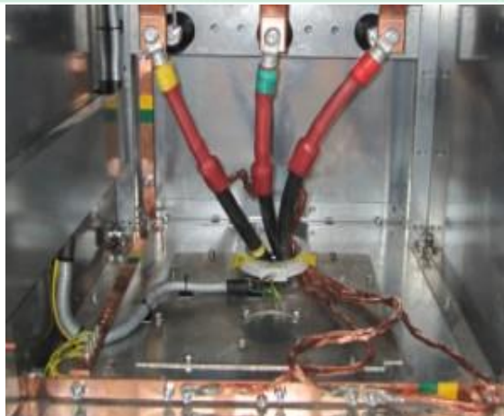
Şəkil 2.8. Sonluq muftası, uc işləmələri və sonluq muftanın birləşdirilməsi
