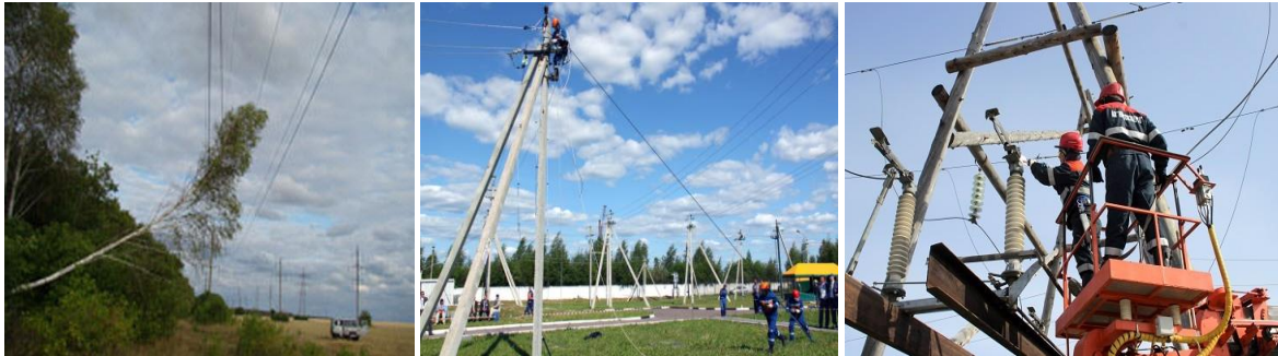
Şəkil 1.8. Açıq hava xətlərinin təmir edilməsi
