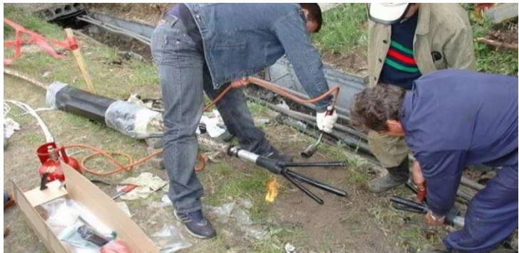
Şəkil 3.12. Kabel xəttinin təmiri
