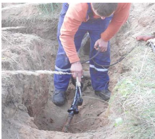
Şəkil 1.11. Kabel xəttinin mufta vasitəsilə təmiri
