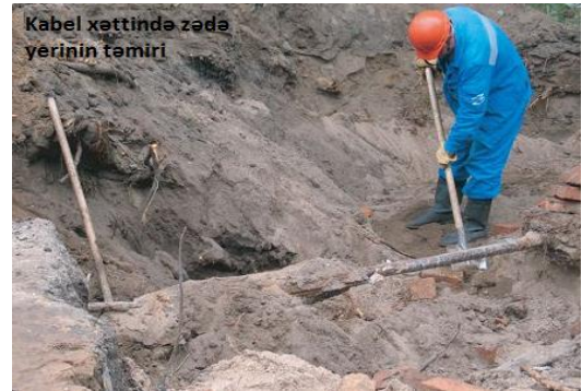
Şəkil 1.12 Kabel xəttinin zədə yerinin təmiri
