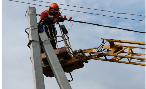
Şəkil 1.21. Hava xəttində yerlə birləşmənin yerinə yetirilməsi
