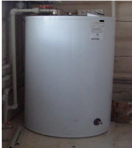
Şəkil 3.23. Yığıcı suqızdırıcı
