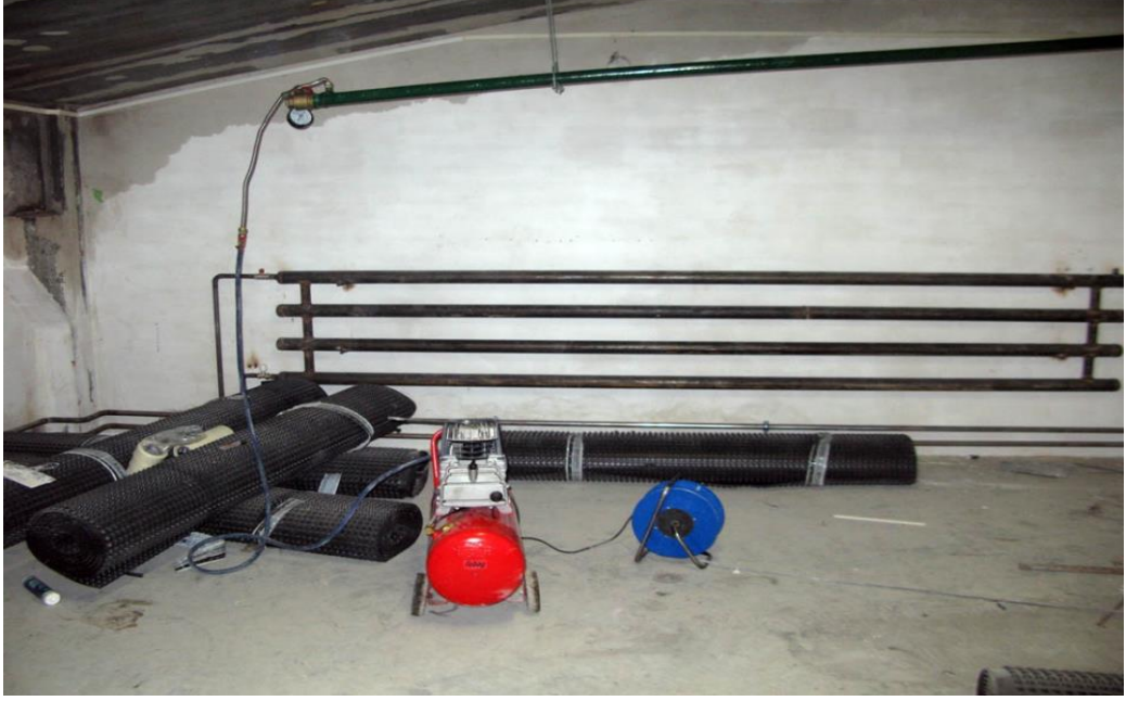
Şəkil 3.32. Təzyiq elektrik nasosu
