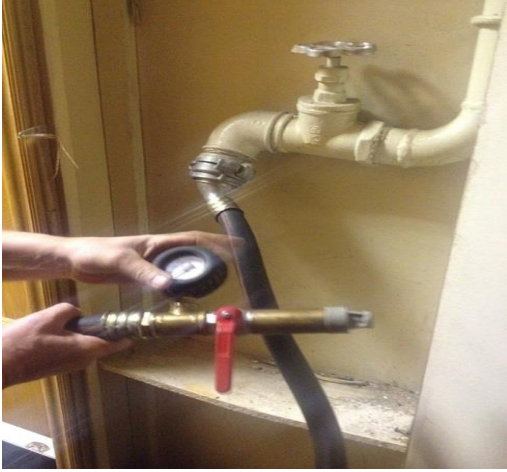
Şəkil 3.34. Daxili su kəmərinin sınağı Şəkil 3.35. Daxili su kəmərinin yuyulması
