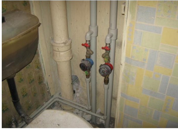
Şəkil 3.10. Su kəmərinin dayaq xətləri
