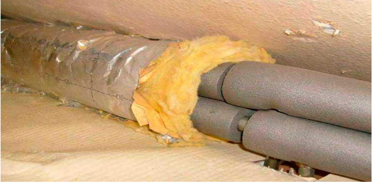
Şakil 3.7. Borunun izolyasiyası
