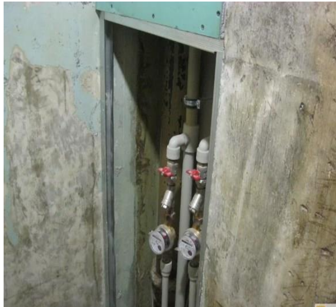
Şəkil 3.11. Su və kanalizasiya dayaqları yan-yana
