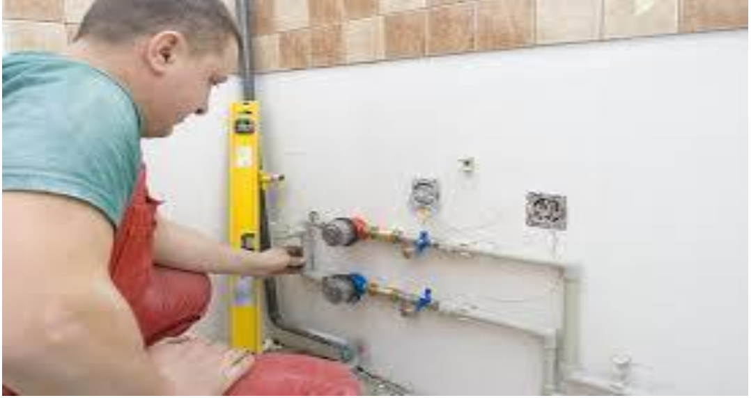
Şəkil 3.16. Suqarışdırıcı kranların quraşdırılması
