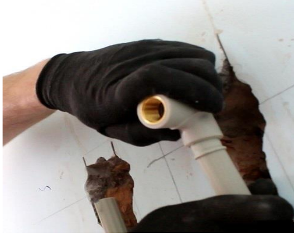
Şakil 3.28. Su xətlərinin dərinlikdə yerləşdirilməsi
