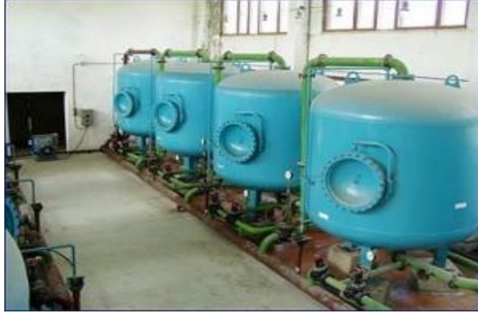
Şəkil 1.13. Su təmizləmə qurğuları
