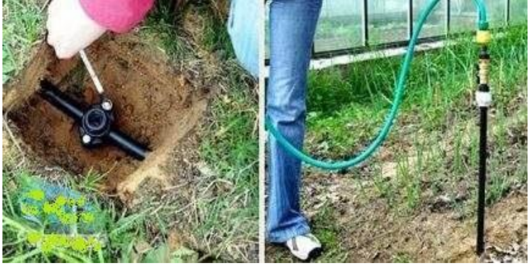
Şəkil 2.15. Sulama kranlarının quraşdırılması
