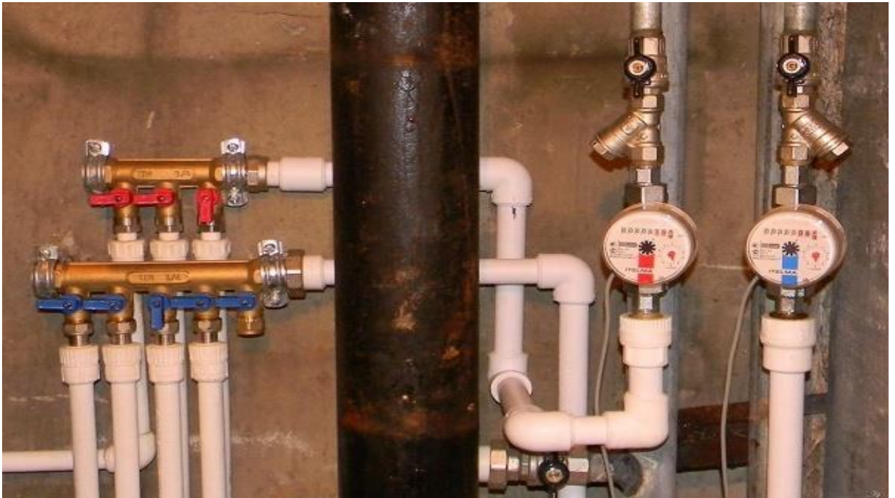
Şəkil 3.15. Su sayğacının quraşdırılması
