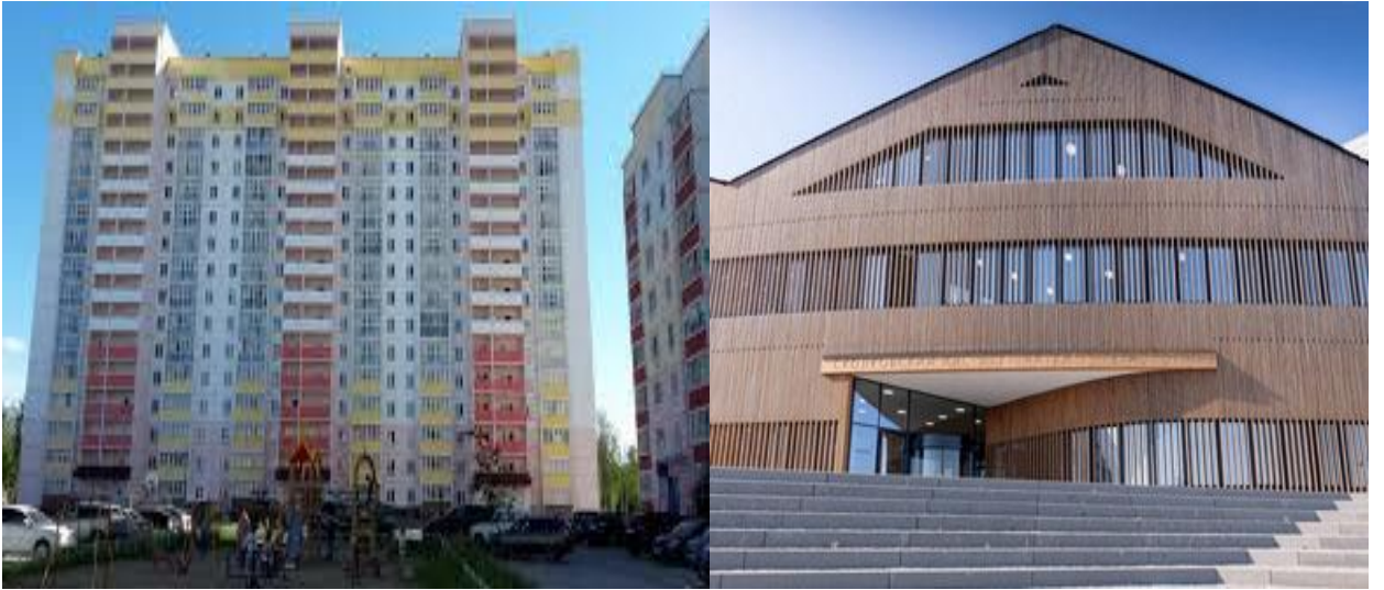
Şəkil 2.24. Yanğın əleyhinə su sistemi quraşdırılan yaşayış və ictimai binalar
