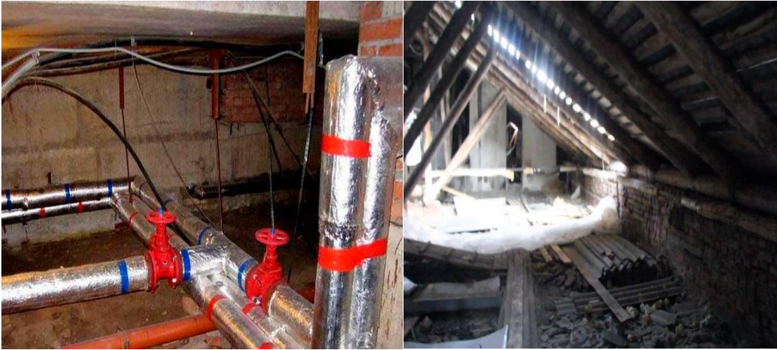
Şakil 3.5. Zirzəmidə magistral boru xətti Şakil 3.6. Çardaqda magistral boru xətti
