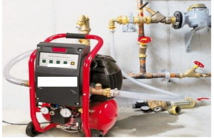
Şəkil 3.34. Daxili su kəmərinin sınağı Şəkil 3.35. Daxili su kəmərinin yuyulması
