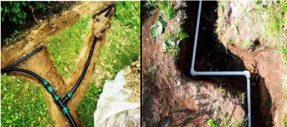
Şəkil 2.12. Sulama su kəmərinin basdırılması
