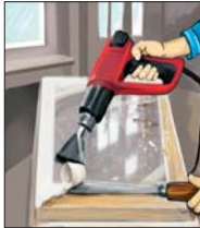
Şəkil 2. Köhnəmiş boyanın inşaat feni ilə çıxarılması
