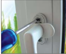
Şəkil 5. Pəncərənin dəstəyinin çıxarılması
