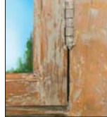
Şəkil 3. Boyası çıxarılan çərçivə
