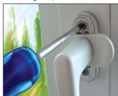
Рис. 5. Снятие ручки окна
