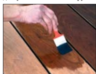
Рис. 2. Нанесение морилки на древесину
