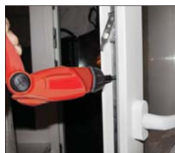
Рис. 6. Снятие фурнитуры
