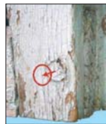
Рис. 5. Скрепление окна нагелем
