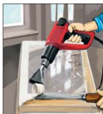
Рис. 2. Снятие старой краски строительным феном
