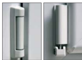
Рис. 3. Снятие декоративного колпачка с петли
