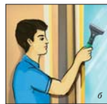
Рис. 8. а) скребком; б) удаление краски скребком
