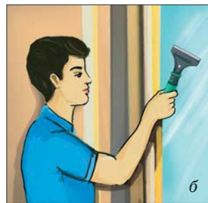
Рис. 8. а) скребок; б) удаление краски скребком
