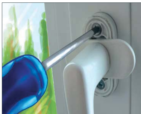
Рис. 5. Снятие ручки окна
