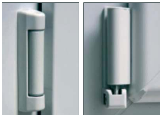
Рис. 3. Снятие декоративного колпачка с петель
