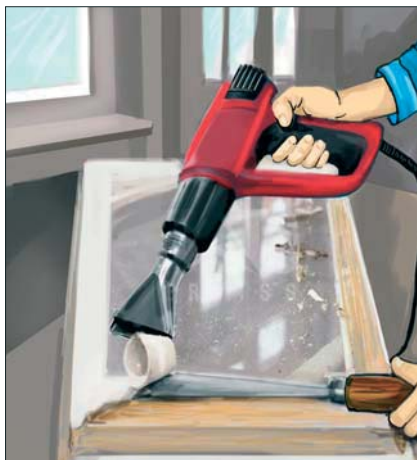
Рис. 2. Снятие старой краски строительным феном
