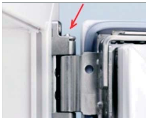
Рис. 4. Вынимание оси из петли
