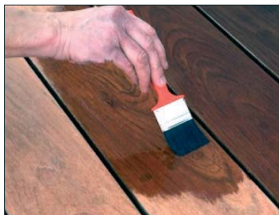
Рис. 2. Нанесение морилки на древесину
