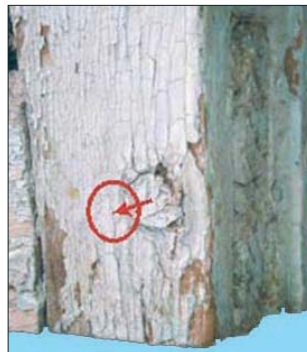
Рис. 5. Скрепление окна нагелем
