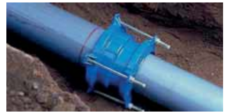
Genişləndirici birləşmələr boruların zədələnmədən genişlənməsinə imkan verir.
