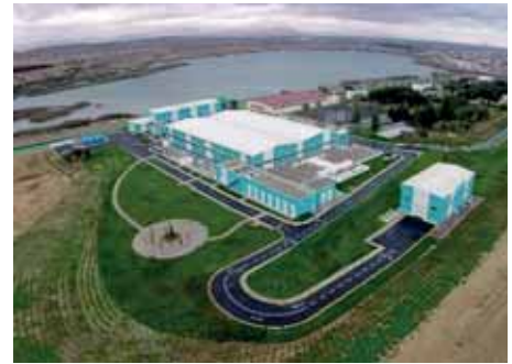
Ceyranbatan su anbarında sutəmizləmə qurğusu
