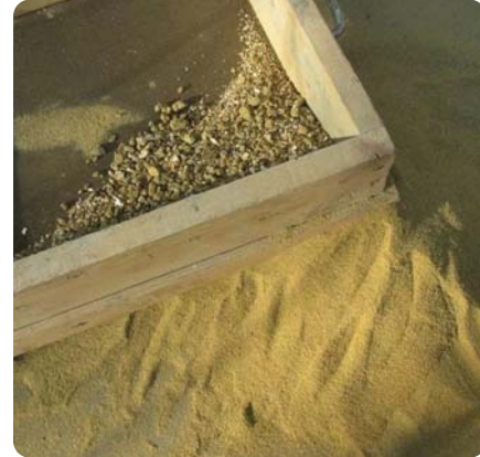
ქვიშა, სანამ გამოიყენება მშენებლობაში, ცრიან სპეციალური წვრილხვრელებიანი საცერით.
