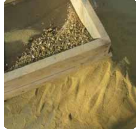
Qumu inşaatda istifadə etməzdən əvvəl xırda dəşikləri olan qum ələyindən keçirirlər.
