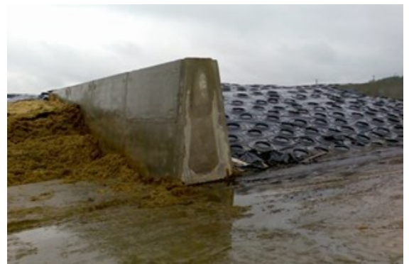
Şəkil 5.30. Xəndəyin çadırının üstünün işlənmiş təkərlərlə basdırılması
