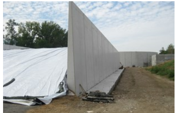
Şəkil 5.29. Xəndəklərin çadırlarla örtülməsi
