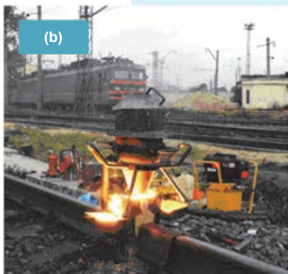
(b) – Alüminotermiya üsulu ilə relslərin qaynaq edilməsi; (c) – qaynaq edilmiş rels.
