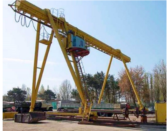
Şəkil 7.3. Kranla işləyərkən kanatın qırılması təhlükə mənbəyidir
