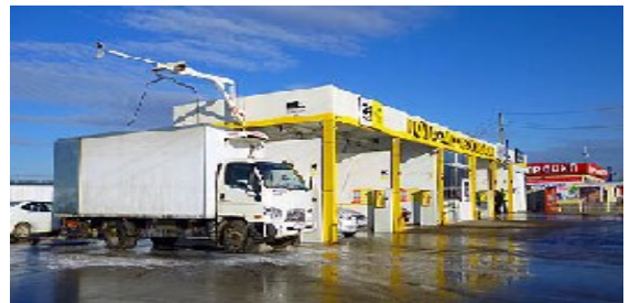
Şəkil 7.10. Texnikanın yuyulması üçün bina
