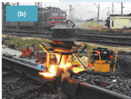
b – Термитная сварка рельсов способом алюминотермии; c – рельс после термитной сварки.
