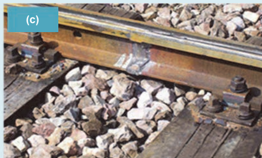
b – Термитная сварка рельсов способом алюминотермии; c – рельс после термитной сварки.
