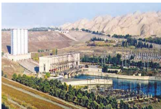
Мингячевирская ГЭС. Гидроузел имеет комплексное значение для нужд энергетики, ирригации, борьбы с селями, водного транспорта, рекреации, спорта.
