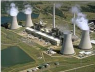
Atom Elektrik Stansiyası
