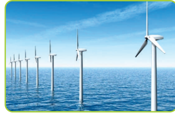
Müasir külək generatorları
