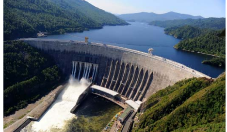
Su elektrik stansiyası
