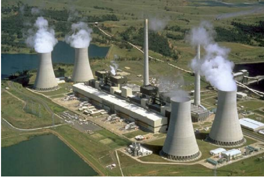
Atom elektrik stansiyası
