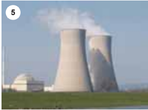
5 Elektrik stansiyalarının inşası
