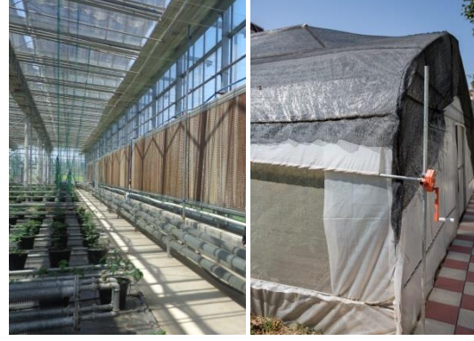
Şəkil 3.38. İstixanada soyuducu radiator və kölgələndirmə
