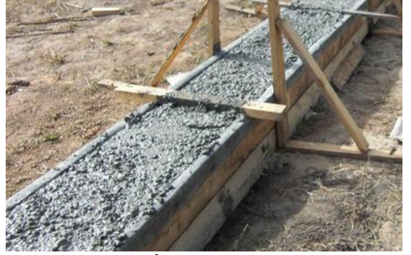
Şəkil 3.25. İstixananın bünövrəsi
