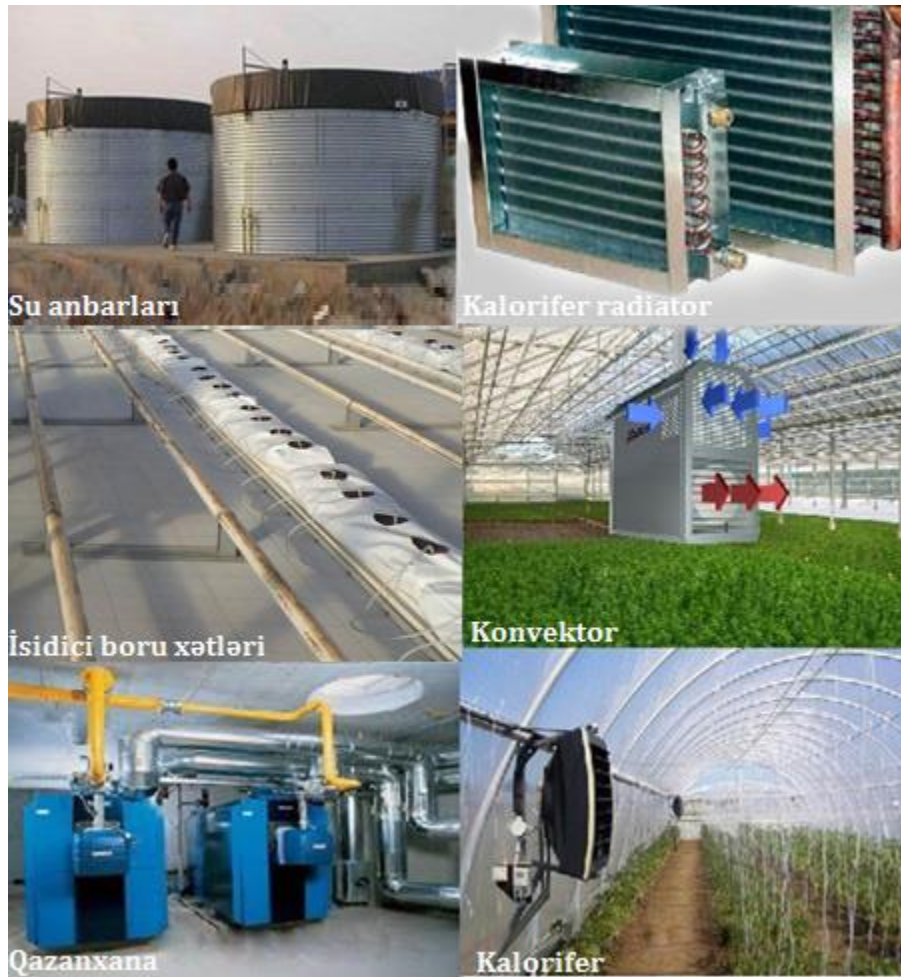
Şəkil 3.30. İstixananın istilik sistemini təşkil edən avadanlıq və qurğular
