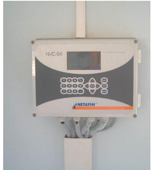
Şəkil 3.40. İstixanada mikroiqlim şəraitini tənzimləyən avtomat qurğu
