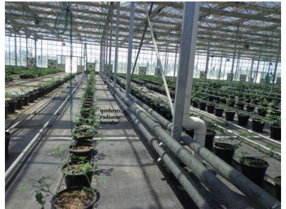
Şəkil 5.9. Adi radiator tipli qızdırıcı borularla təchiz edilmiş istixana
