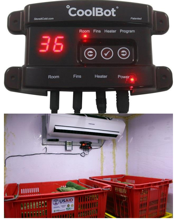
Şəkil 6.7. Coolbot sistemli mini soyuducu anbar
