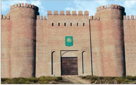
Gəncə darvazası və qala divarı. Müasir görünüşü
