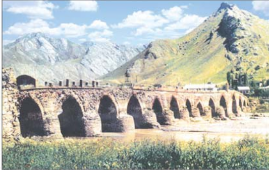
Xudafərin köprüsü. Cəbrayıl rayonu. Hazırda bu abidəmiz erməni işğalı altındadır
