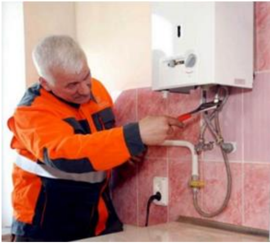
Şəkil 3.10. Qaz suqızdırıcısının qoşulma sxemi
