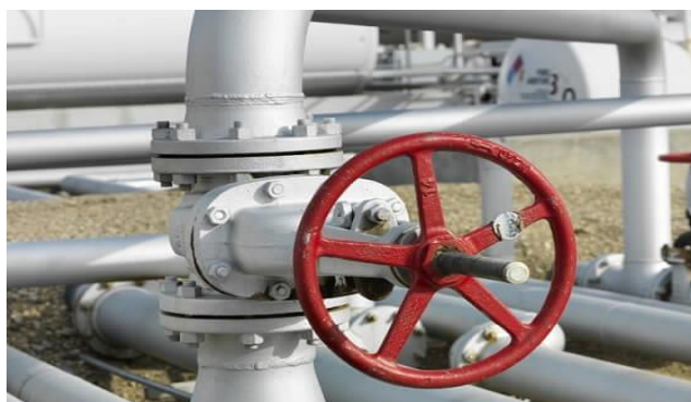
řakil 1.10. Qaz boru xətti  c n baėlayıcı armaturun qurařdırılması
