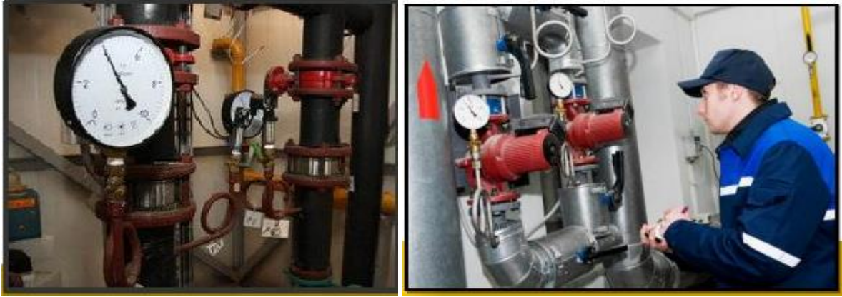
Şəkil 2.13. Qaz boru kəmərinin hidravlik üsulla sınağı
