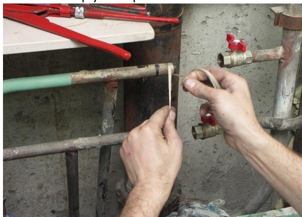
Şəkil 2.23. Binadaxili qaz kəmərinin təmiri
