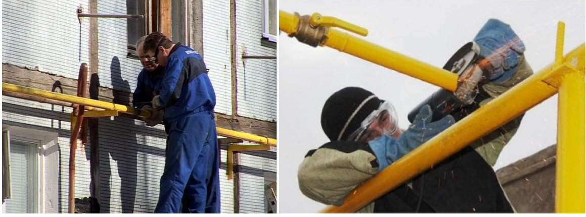
Şəkil 2.20. Məhəllədaxili qaz boru kəmərinin təmiri
