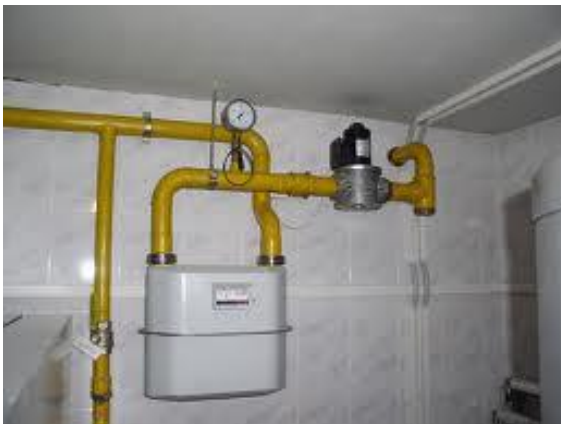
Şəkil 1.11. Qaz kəmərinin daxili çəkilmə üsulu
