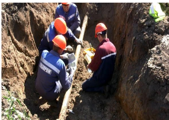
Şəkil 2.19. Qaz boru kəmərinin əsaslı təmiri
