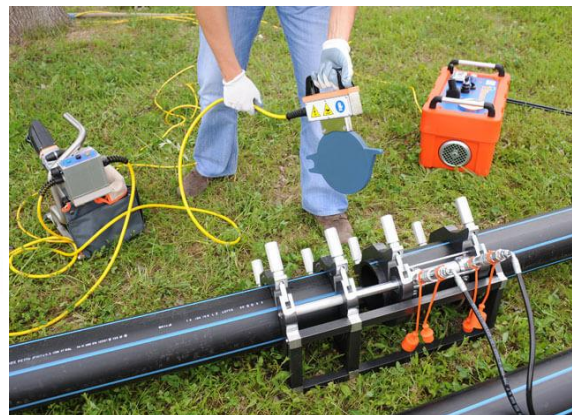
Şəkil 1.17. Polietilen borunun lehimlənmə prosesi
