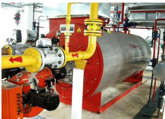
řakil 3.20. Par qazanxanasına qaz qorelkasının quraşdırılması
