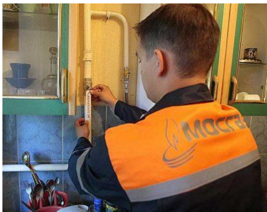
Şəkil 2.22. Mətbəxdə qaz borusunun təmiri
