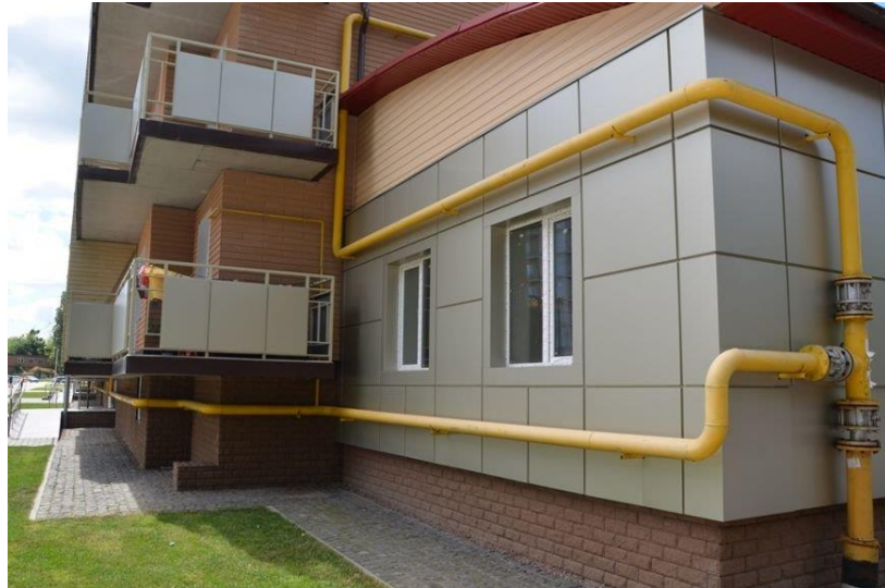
Şəkil 1.5. Binaxaricində qaz xəttinin çəkilməsi
