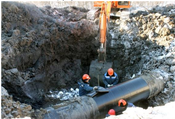
Şəkil 2.18. yeraltı qaz boru kəmərinin izolyasiyasının təmiri
