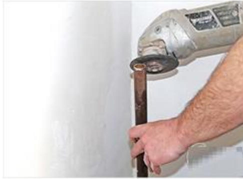
Şəkil 2.1. Trubanın ağzının bərabərləşdirilməsi
