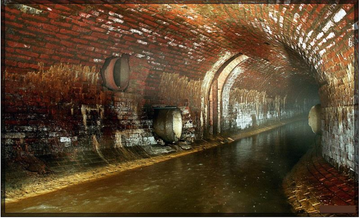
Şəkil 1.10. Boruların birləşdiyi kanalizasiya kollektoru
