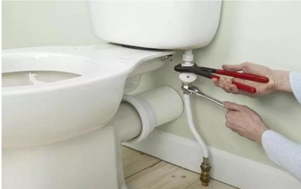
Şəkil 3.17. Yuyucu çənin xəttə quraşdırılması
