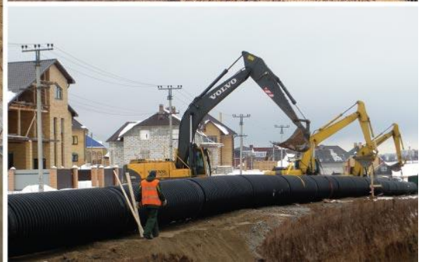
Şəkil 1.19. Borunun xəndəyə qoyulması
