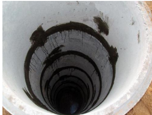
Şəkil 2.29. Daxildən izolyasiya olunmuş quyuyu
