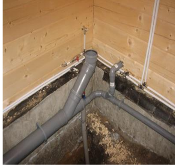
Şəkil 2.32. Mənzildaxili kanalizasiya xətlərinin çəkilişi
