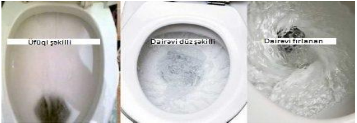
Şəkil 3.11. Tualet çanağında suyun axma formaları
