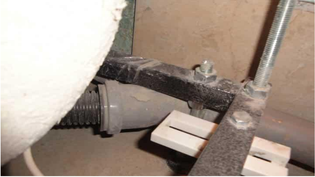
Şəkil 3.49. Vanna sifonunun kanalizasiya xəttinə qoşulması
