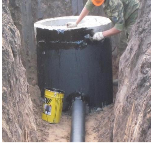
Şəkil 2.30. Xaricdən izolyasiya olunmuş quyuy
