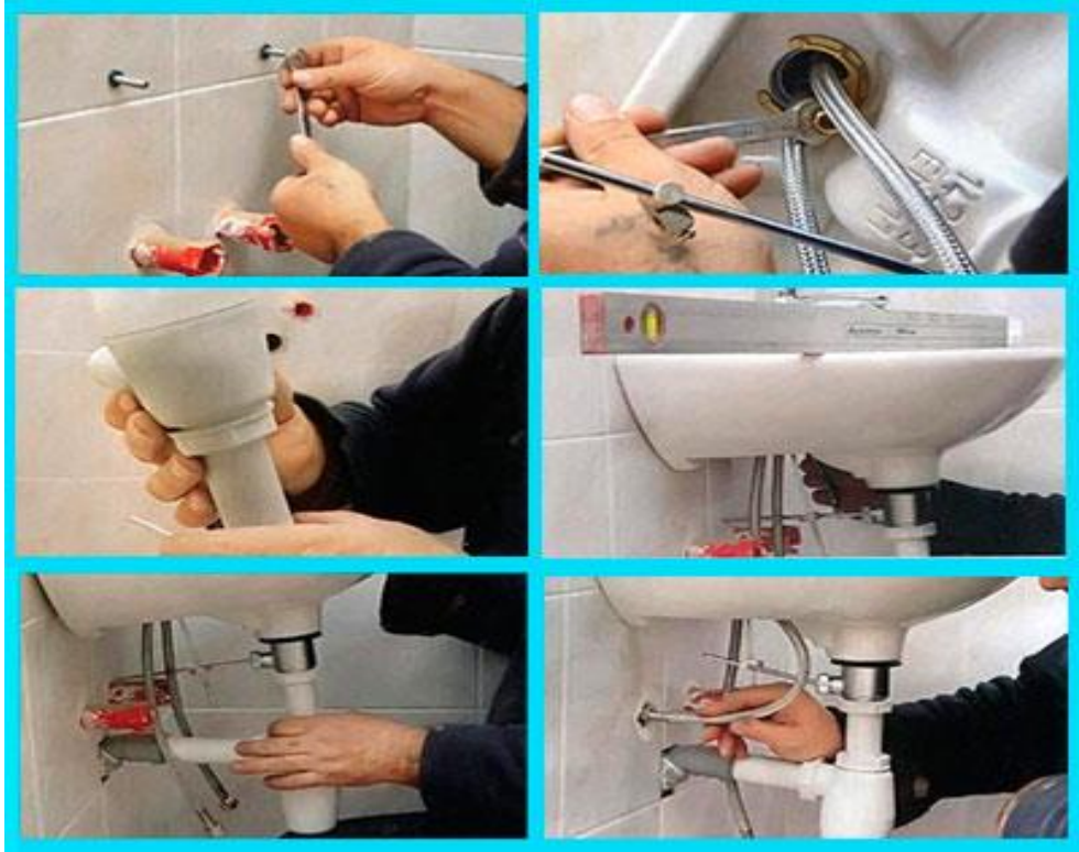
Şəkil 3.33. Əl-üz yuyanın quraşdırılma ardıcılığı
