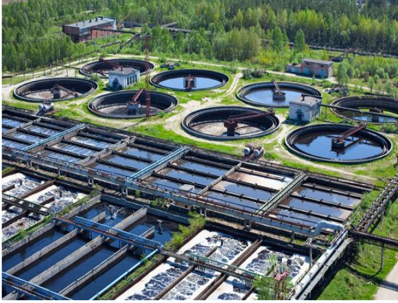
Şakil 1.2. Təmizləyici stansiya
