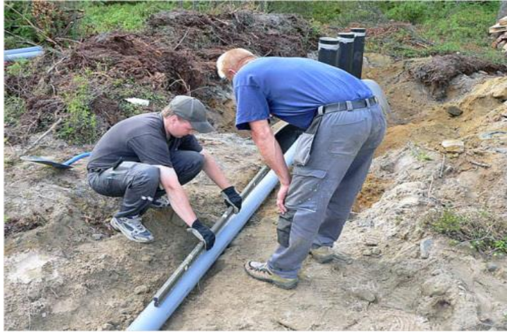
Şəkil 2.28. Öz özünə axan kanalizasiya borularında mailliyin yoxlanılması
