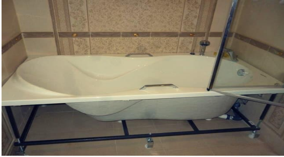
Şəkil 3.51. Akril vanna metal karkas üzərində
