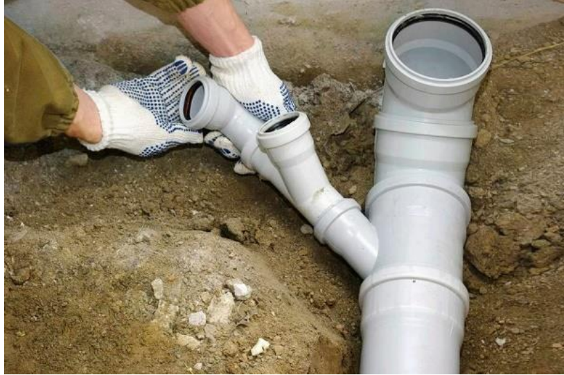
Şəkil 2.45 Kanalizasiya boruların yığılması
