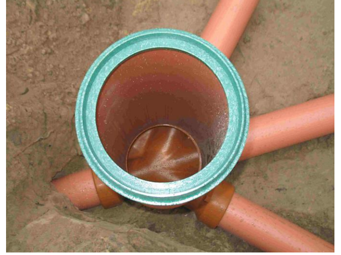
Şəkil 1.18. Plastik baxış quyusu
