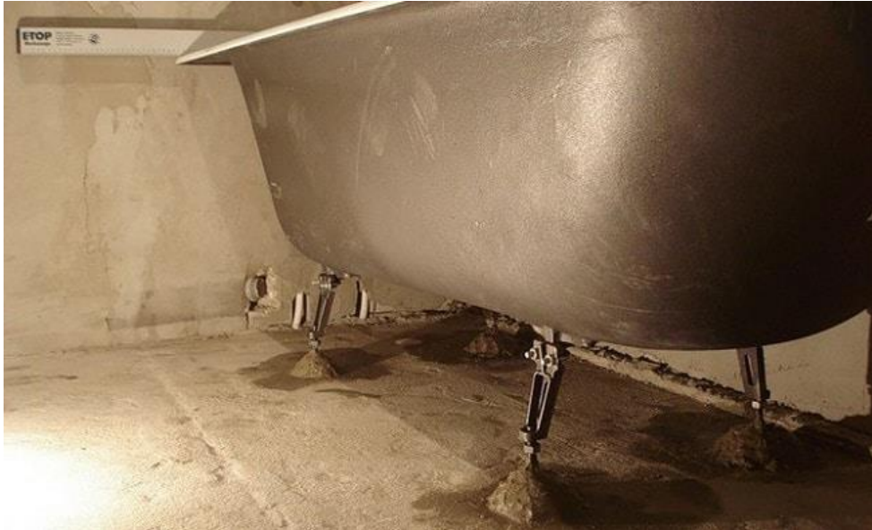
Şəkil 3.57. Vannanı yerləşdirmək üçün döşəmənin düzləndirilməsi
