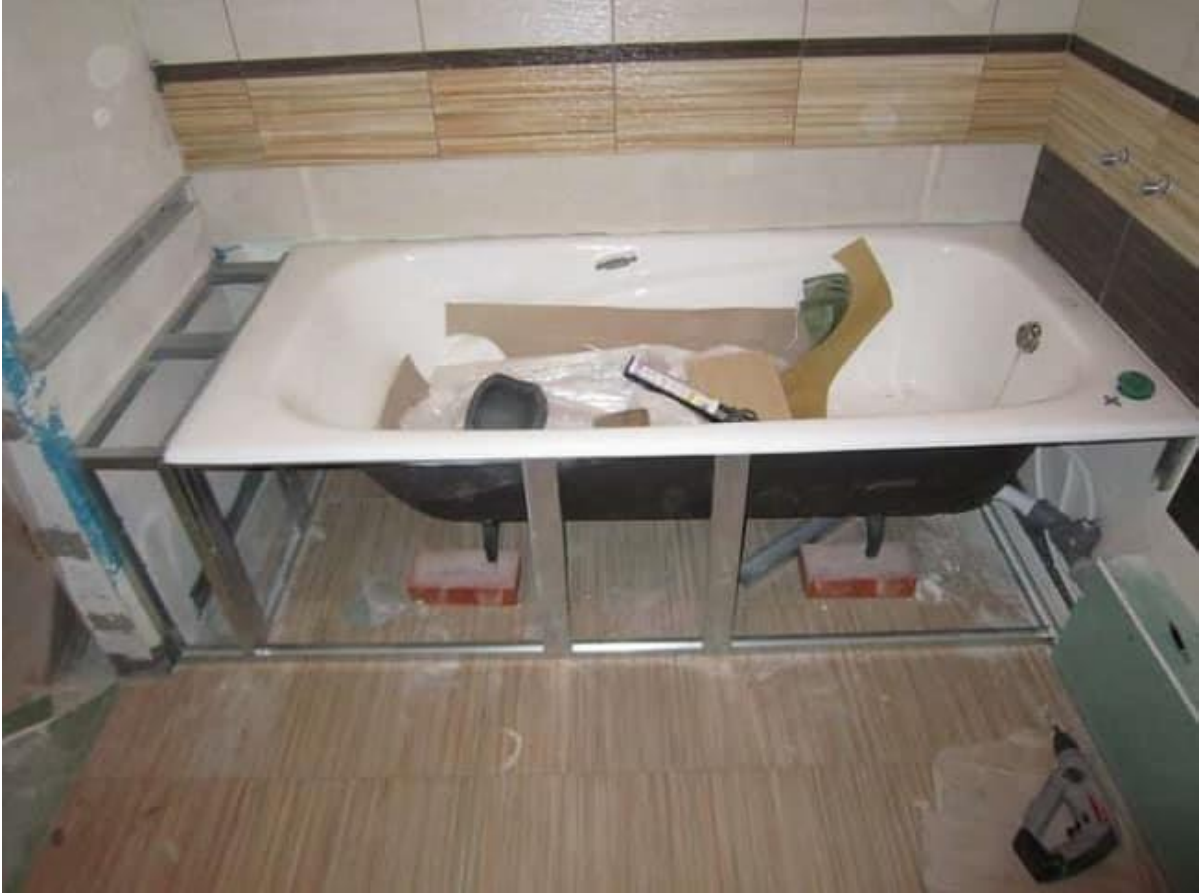
Şəkil 3.56. Çuqun vannanın quraşdırılması
