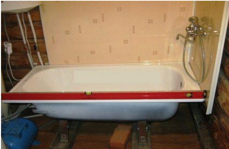
Şəkil 3.55. Vannanın düzlüyünün tərəzi ilə yoxlanılması
