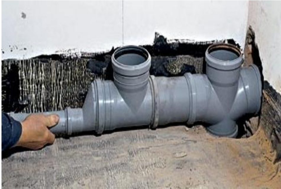
Şəkil 2.2. Sanitar qovşağında boruların birləşməsi
