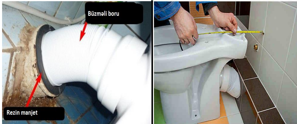
Şəkil 3.16. Çanağın büzməli boru vasitəsilə quraşdırılması
