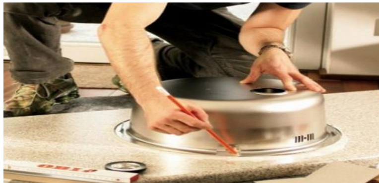
Şəkil 3.39. Mətbəx çanağının kənar konturunun çəkilməsi
