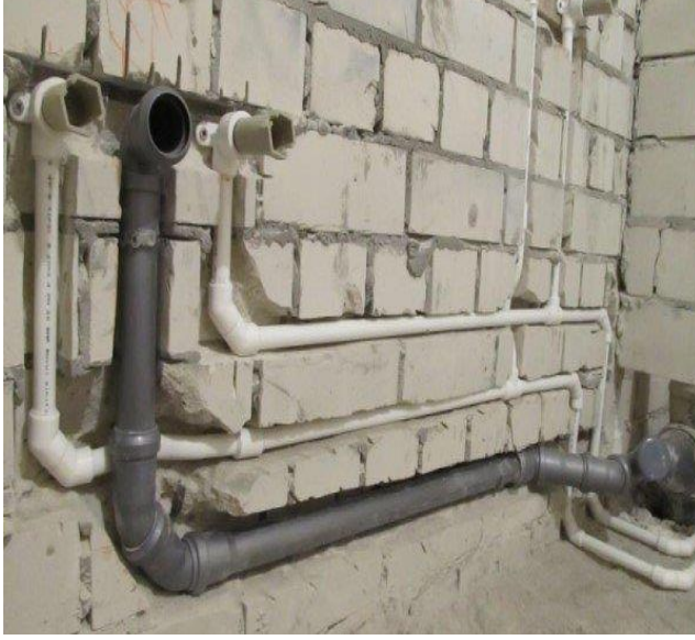
Şəkil 2.32. Mənzildaxili kanalizasiya xətlərinin çəkilişi
