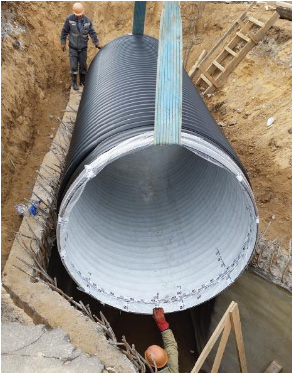
Şəkil 1.19. Borunun xəndəyə qoyulması
