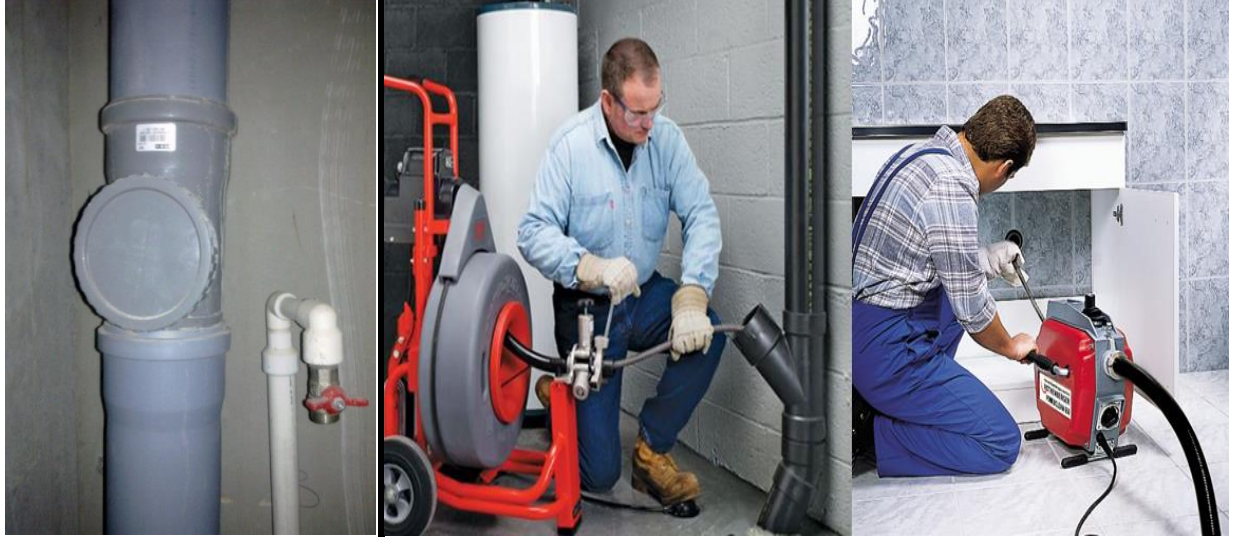
Şəkil 1.28. Təftiş fasonlu hissəsi və təmizləmə prosesi
