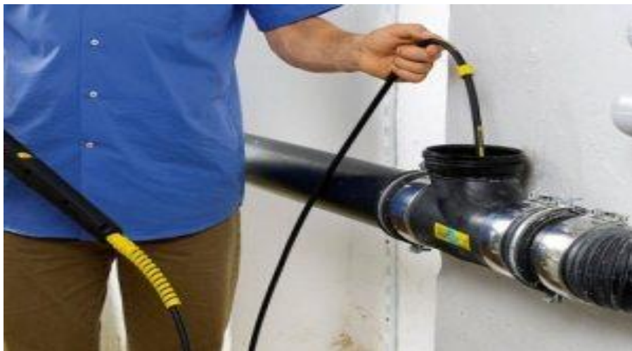
Şəkil 1.29. Təmizləmə fasonlu hissəsindən təmizləmə prosesi
