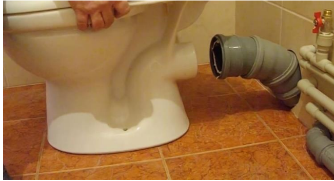
Şəkil 3.15. Çanağın birbaşa dayağa quraşdırılması
