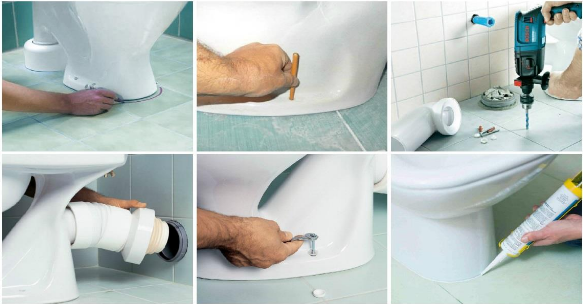
Şəkil 3.18. Tualet çanağının döşəməyə bərkidilməsi
