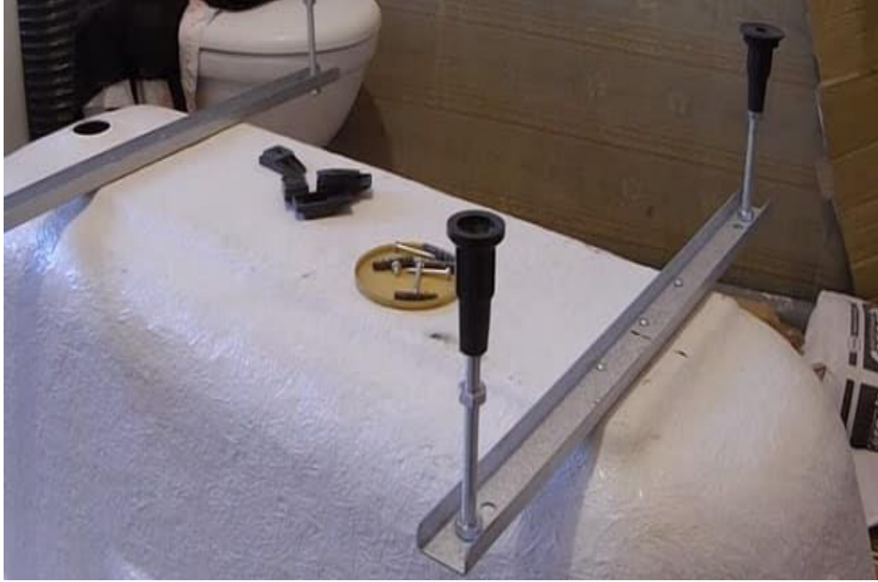
Şəkil 3.54. Akril vannanın dayaqlarının bərkidilməsi
