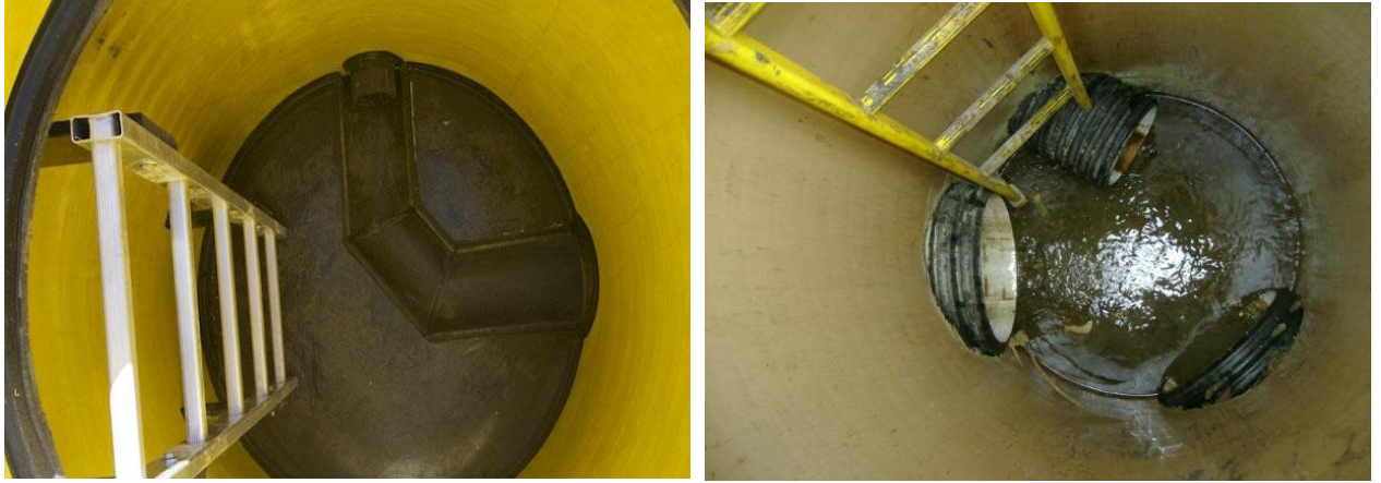
Şəkil 1.24. Quyuda boruların birləşməsi
