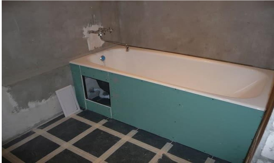
Şəkil 3.53. Vannanın ön tərəfinin bağlanması
