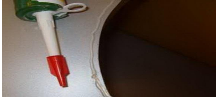
Şəkil 3.41. Çanağın oturacaq yerinin hermetiklənməsi
