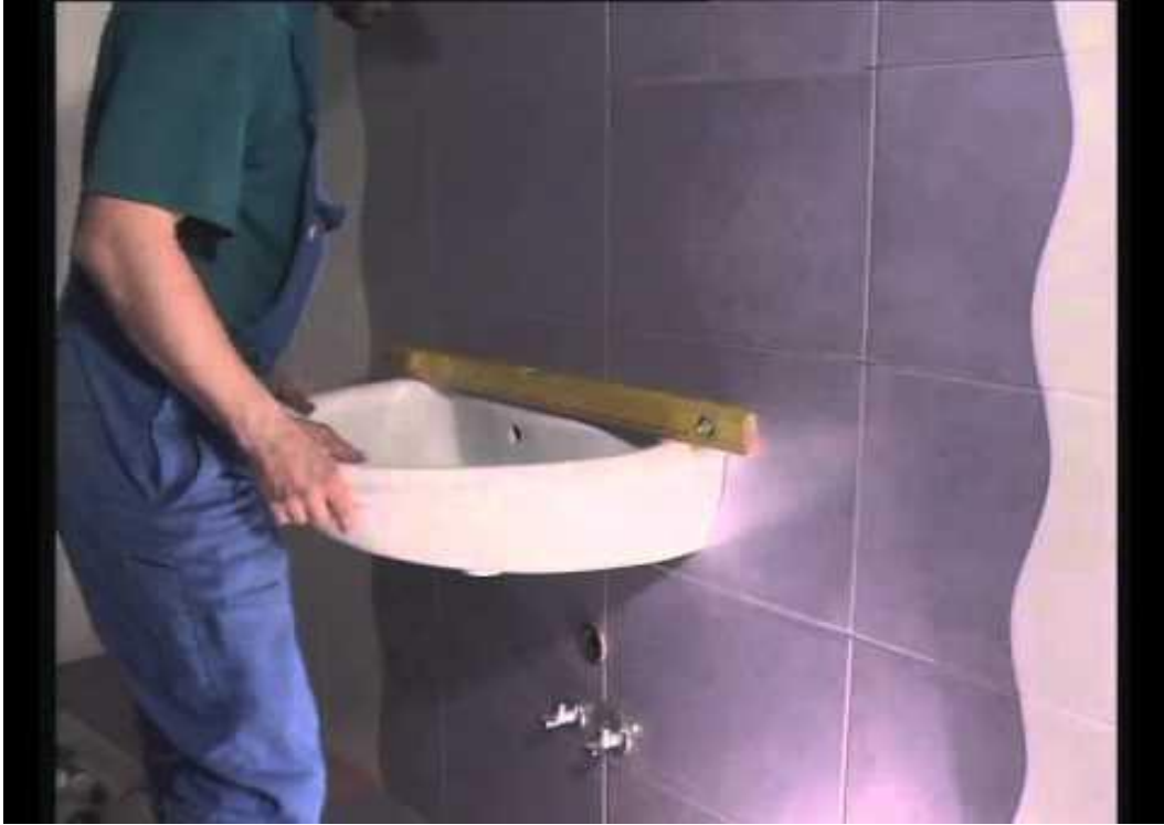
Şəkil 3.32. Əl-üz yuyanın quraşdırılması
