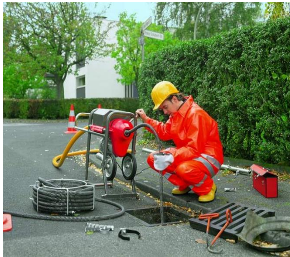
Şəkil 2.34. Elektromexaniki üsul ilə təmizləmə
