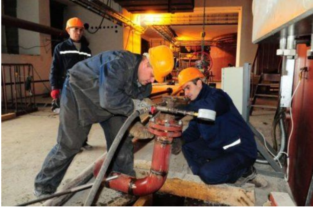
Şəkil 2.20. Kanalizasiya sisteminin sınaqdan keçirilməsi
