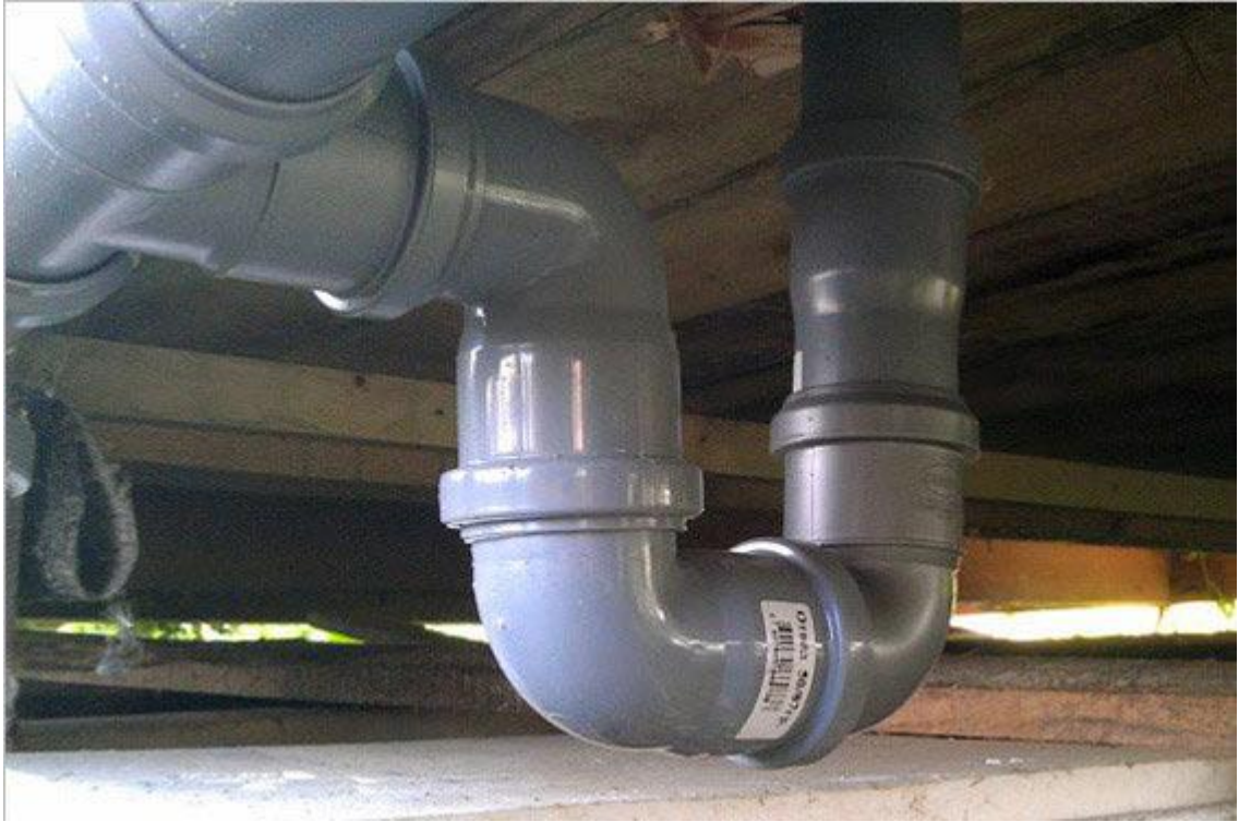
Şəkil 2.40. Hidravlik qapayıcının işləməsi
