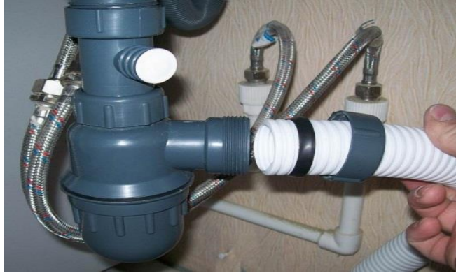
Şəkil 3.43. Çanağın kanalizasiya xəttinə birləşdirilməsi
