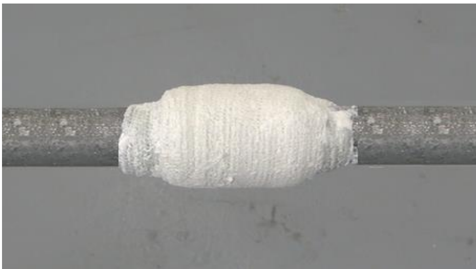
Şəkil 2.43. Sızmanın aradan qaldırılması
