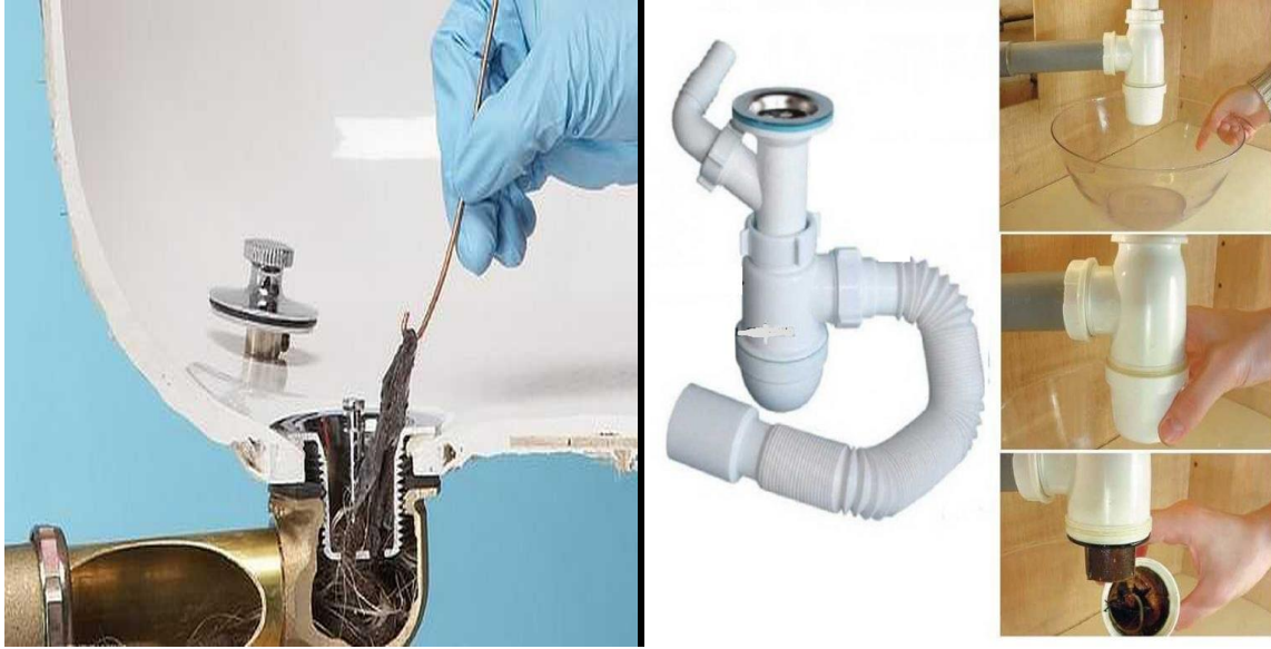
Şəkil 2.37. Sifondan çirkin təmizlənməsi
