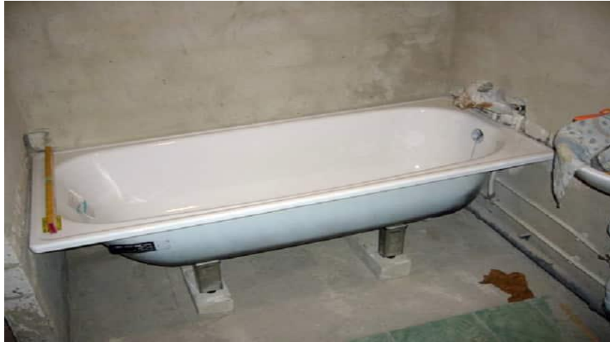
Şəkil 3.59. Dəmir vannanı quraşdırılması
