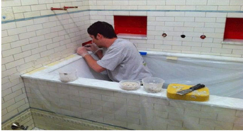
Şəkil 3.52. Vannanın divara oturan hissəsinin hermetikləşməsi
