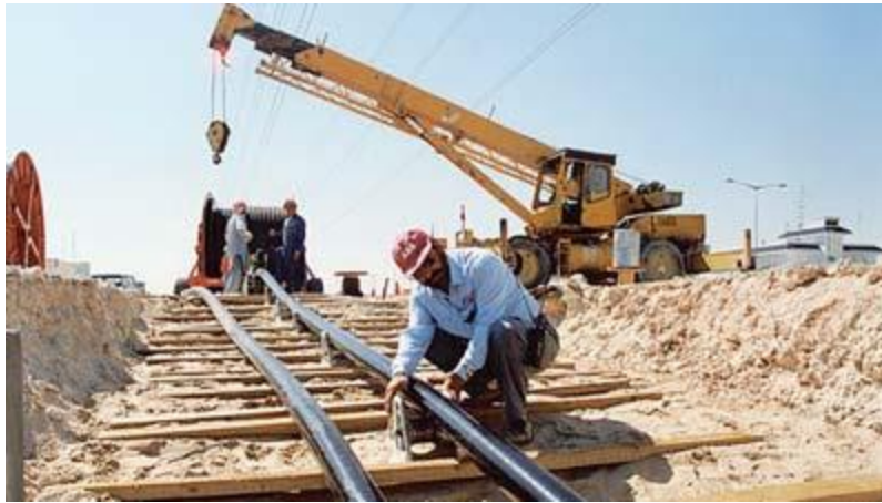
Şəkil 5.4. Trassanın profili üzrə kabel xətlərinin çəkilməsi
