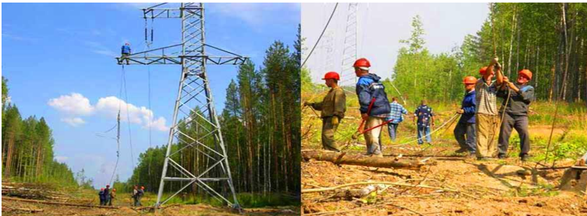
Şəkil 1.1. Hava xətlərinin çəkilməsi
