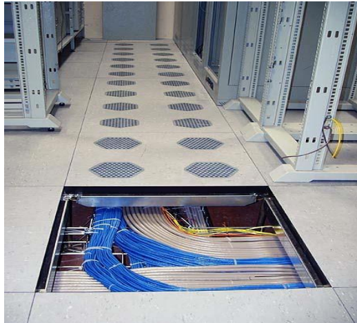
Şəkil 4.7. Gizli elektrik xətlərinin quraşdırılması
