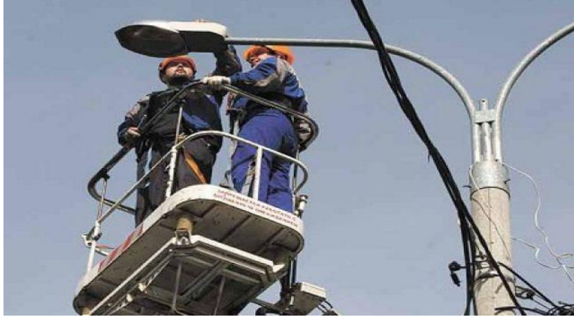
Şəkil 4.3. Küçə işıqlandırılma-sının quraşdırılması
