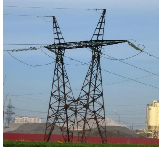
Şəkil 1.15. Bir dövrəli anker dayağı
