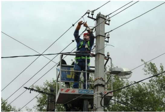
Şəkil 4.1. Açıq hava xəttinin quraşdırılması
