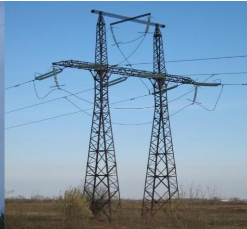
Şəkil 1.17. Transpozisiya dayaqlar
