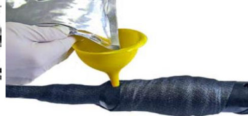
Şəkil 1.22. Muftanın soyuq üsulla hermetikləşdirilməsi
