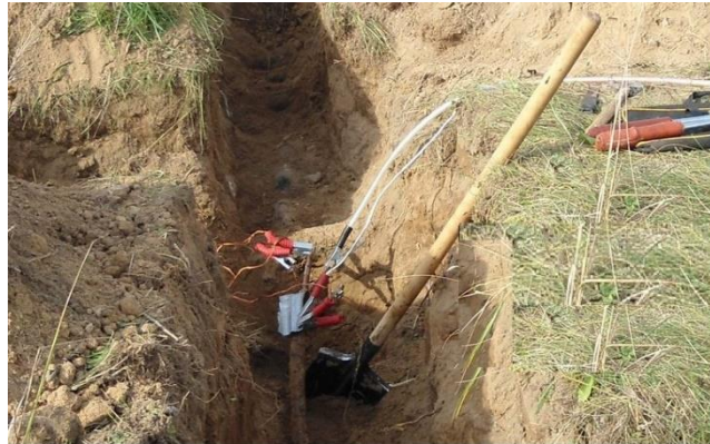
Şəkil 3.5. Kabel xəttinin sınağı
