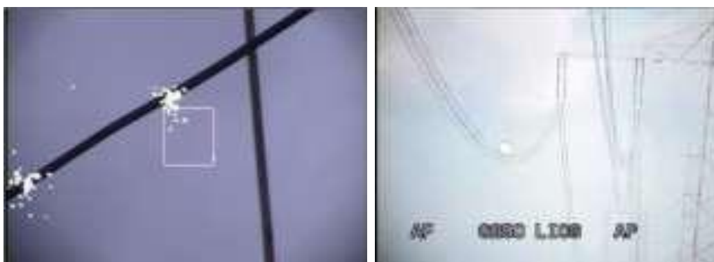
Şəkil 1.3. APQ –şinlərin elementar keçiricilərinin (solda) və yüksək voltlu xətlərin elementar keçiricilərinin (sağda) zədələrində tac boşalması
