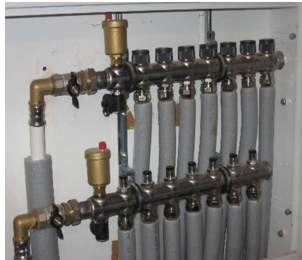
Şəkil 2.15. Kollektor sxemi
