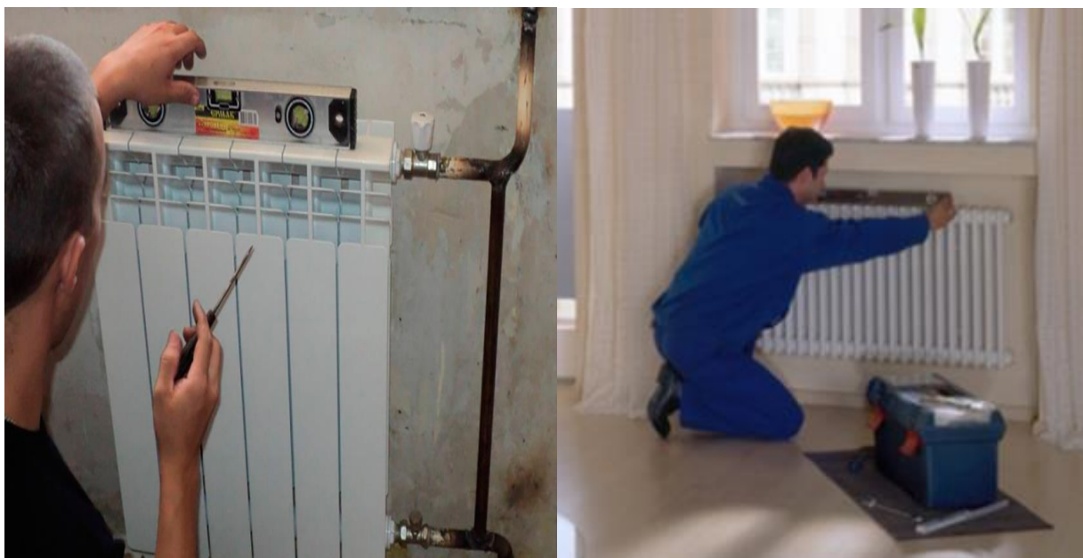
Şəkil 3.27. Radiatorların tarəzi vasitəsilə asılması
