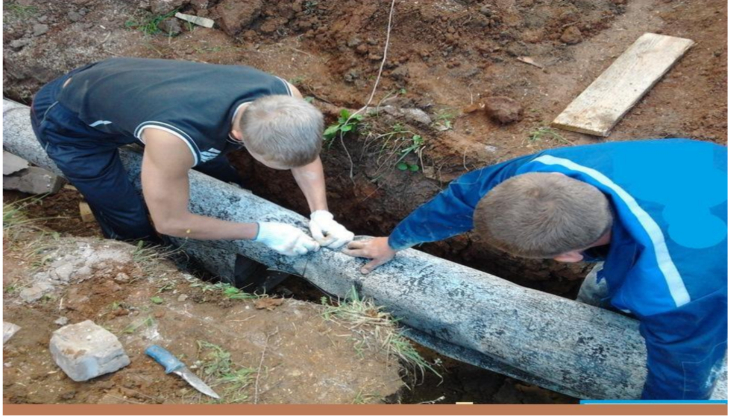
Şəkil 3.4. Borunun izolyasiyası
