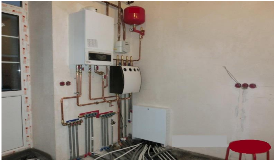
Şəkil 1.39. Avtonom istilik sisteminin quraşdırılması
