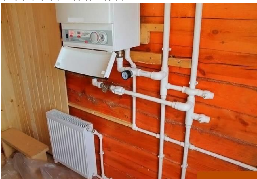
Şəkil 2.12. Mənzildaxili istilik sisteminin quruluşu
