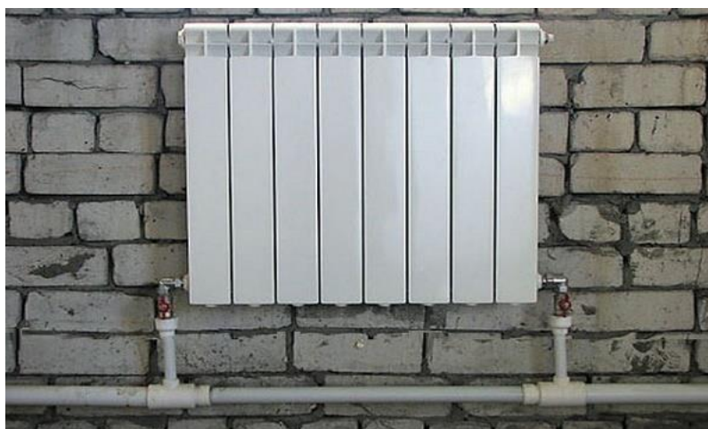
Şəkil 2.1. Birborulu təbii dövretmə istilik sistemi.
