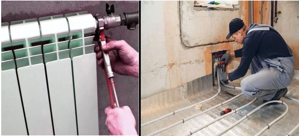
Şəkil 2.8. İstilik sisteminin quraşdırılması işləri
