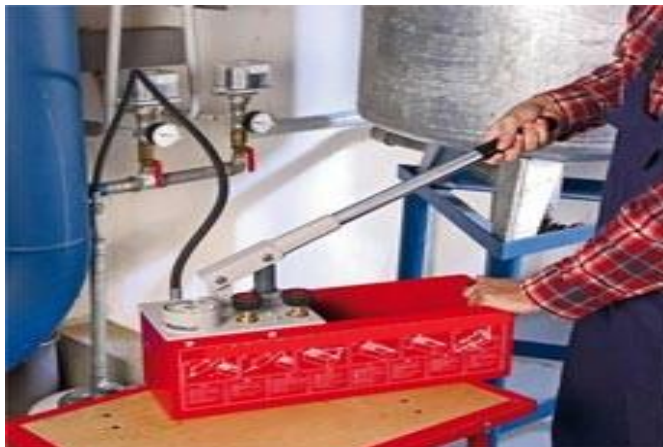
Şəkil 3.34. Əl nasosunun qoşulması
