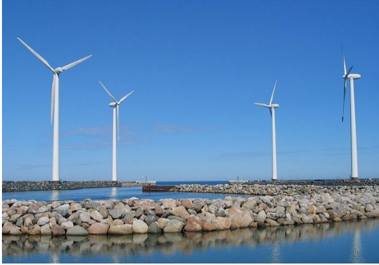
Şəkil 6. 3. Külək elektrik stansiyası
