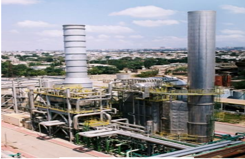
Şəkil 6. 4. İstilik elektrik stansiyası
