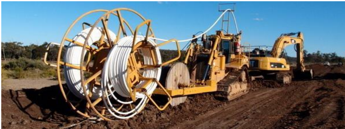
Şəkil 1.32 Kabel xəttinin çəkilməsində maşın və mexanizmlərdən istifadə
