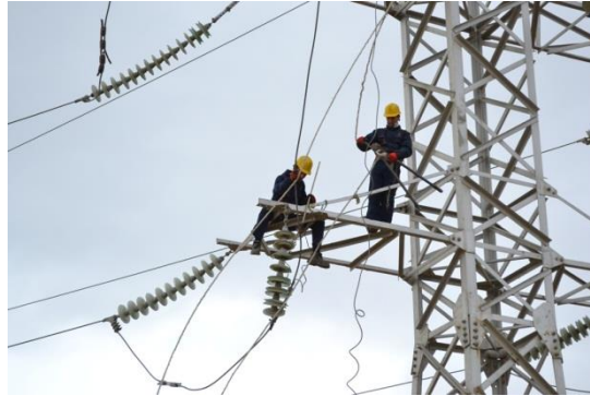
Şəkil 2.10. Hava elektrik xəttinin təmiri
