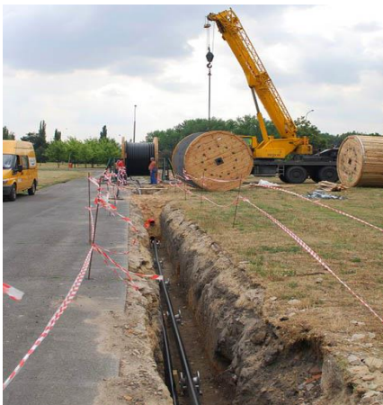
Şəkil 1.30 Texnika vasitəsilə kabelin barabandan açılması
