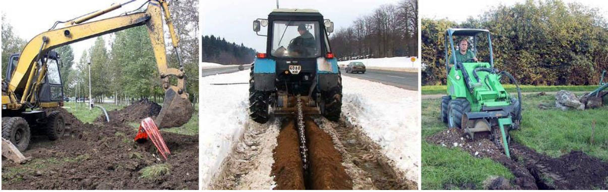
Şəkil 3.5 Texnikalar vasitəsilə xəndəyin qazılması
