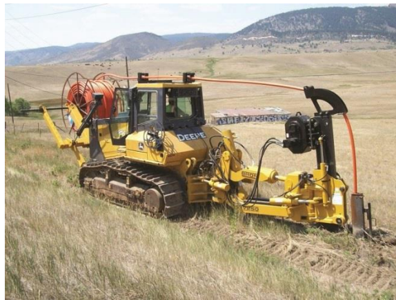
Şəkil 1.31 Texnika vasitəsilə xəndəyin qazılması və kabelin açılması
