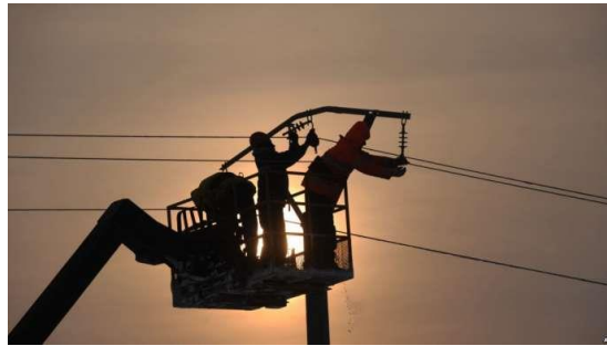
Şəkil 2.11 Kabelin quraşdırılması
