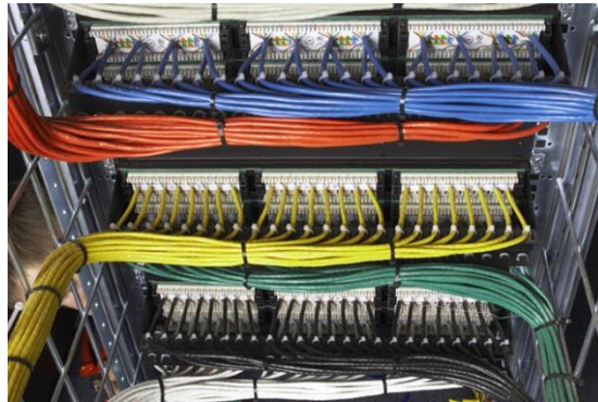
Şəkil 4.3 kabellərin testləşdirilməsi
