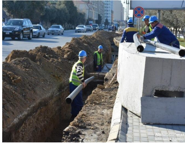
Şəkil 2.8 Kabelin xəttinin plastik borularla çəkilməsi
