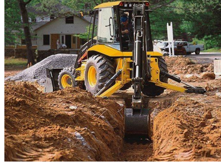
Şəkil 3.4 Maşın və mexanizmlərdən istifadə edilərək xəndəyin qazılması
