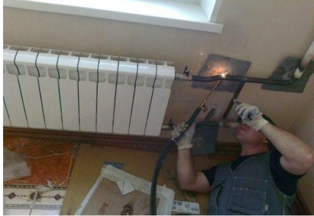
Şəkil 2.13. Boruların qaynaq edilməsi.
