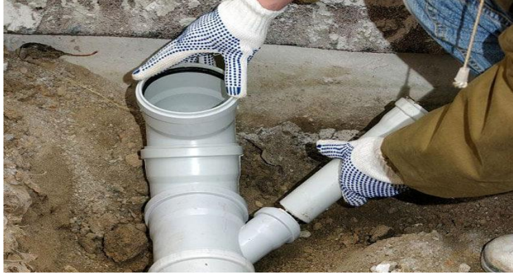
Şəkil 2.26 Polietilen kanalizasiya borularının birləşdirilməsi
