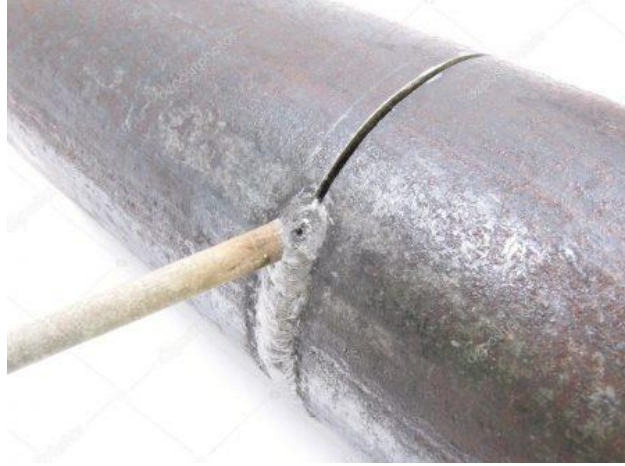
Şəkil 2.9 Elektrik qövs qaynağı
