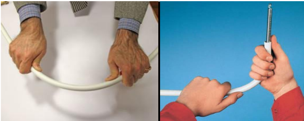
Şəkil 3.11 Metalloplastik boruların əl ilə əyilməsi.
