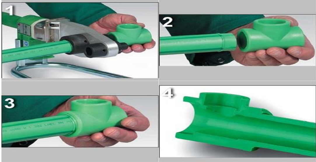
Şəkil 2.15 Qaynaq ardıcılığı
