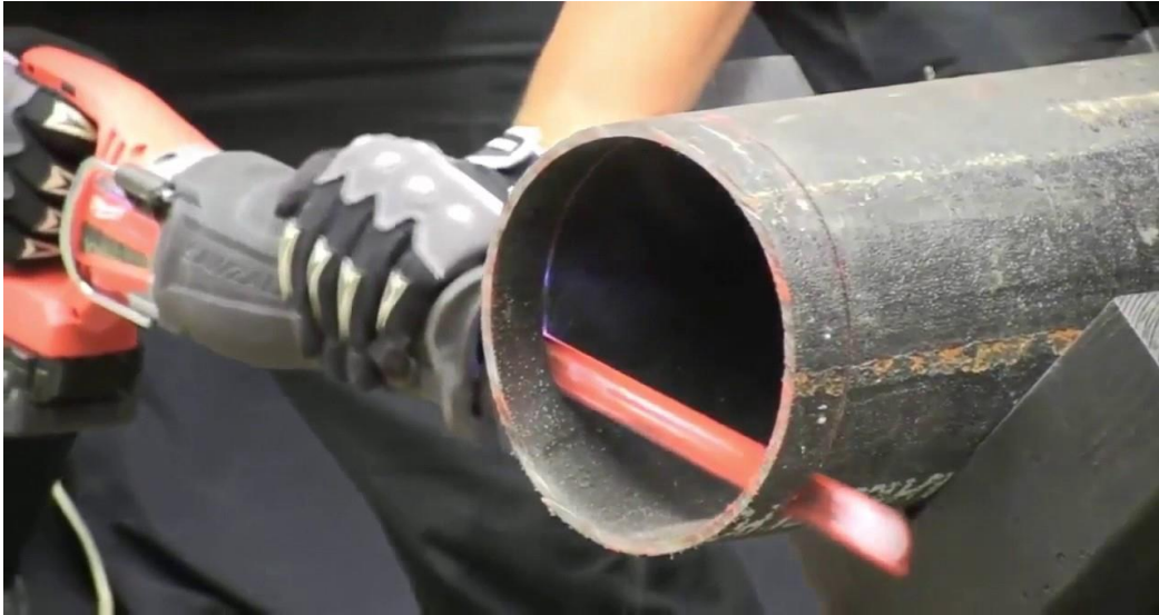
Şəkil 1.23 Metal borunun kəsilməsi əməliyyatı
