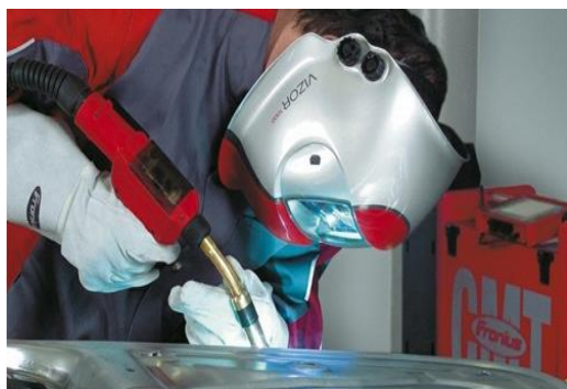
Şəkil 3.2. Antikoroziya müalicəsi, qaynaq işləri
