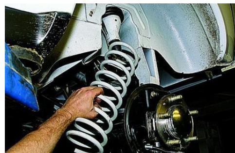
Şəkil 5.15 Yayların yerlərinə quraşdırılması
