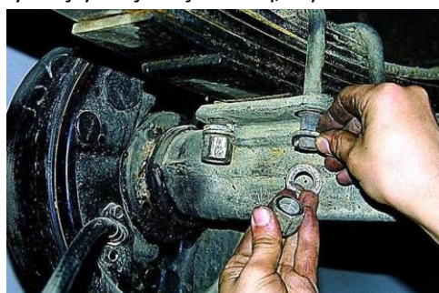
Şəkil 5.13 Yığılmış ressorun quraşdırılması
